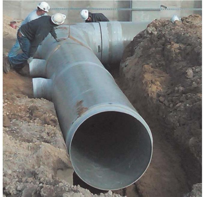
et aisée. La conduite FRP est également imperméable aux minéraux ou aux sels présents dans le sol.
