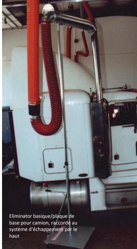
Eliminator basique/plaque de base pour camion, raccordé au système d'échappement par le haut
