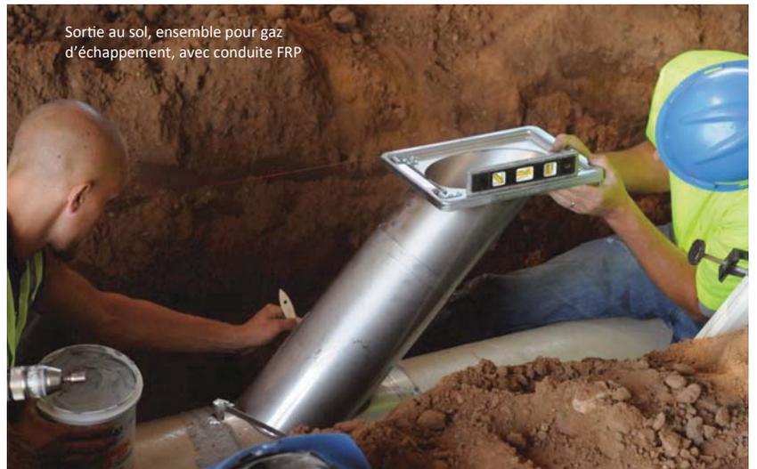
Sortie au sol, ensemble pour gaz d'échappement, avec conduite FRP
